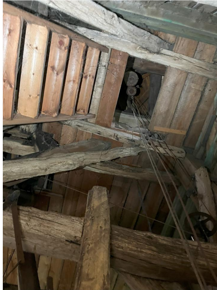
Kirchturmschacht Gewichte oben im Turm
