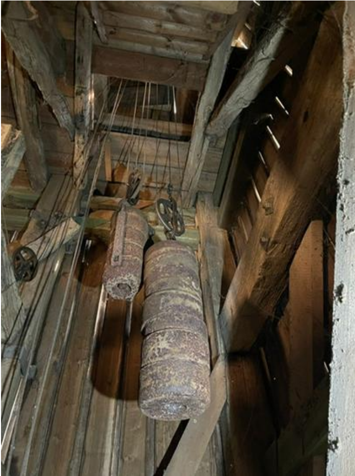
Kirchturmschacht Gewichte für Gehwerk, Schlagwerk
